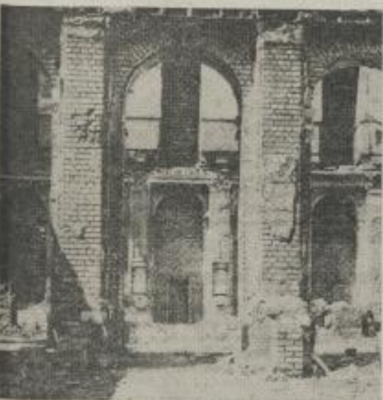
Ruinen und Trümmer - das blieb 1945 von den meisten Gebäuden der Universität übrig. Unsere Fotos zeigen die
