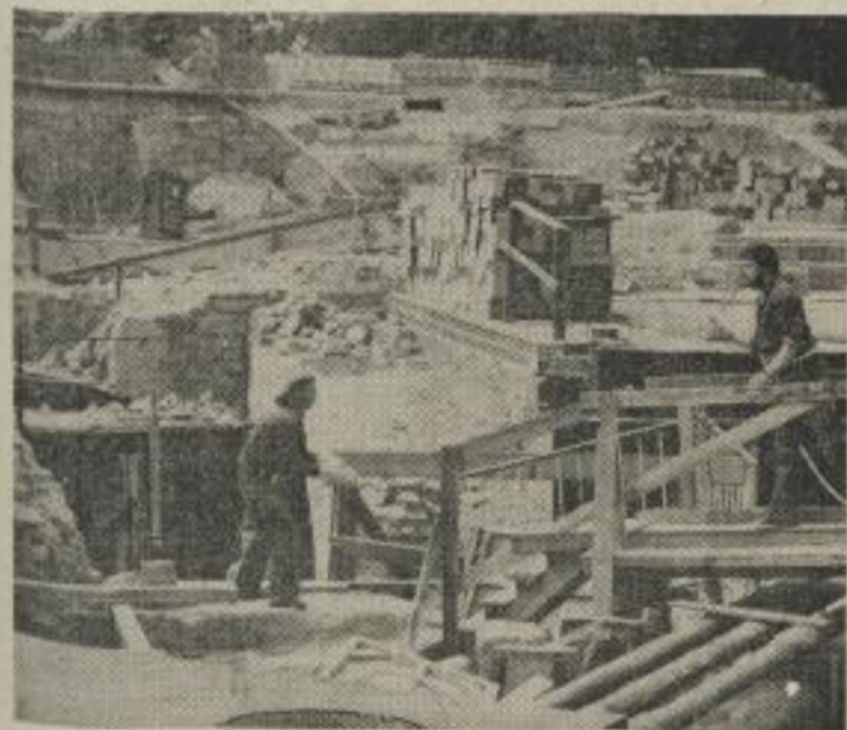
An der Moritzbastei gehen die Arbeiten zügig weiter. Gegenwärtig arbeiten hier etwa 30 Studenten des 1. Studienjahres. Foto: HFBS UZ, Rostock
