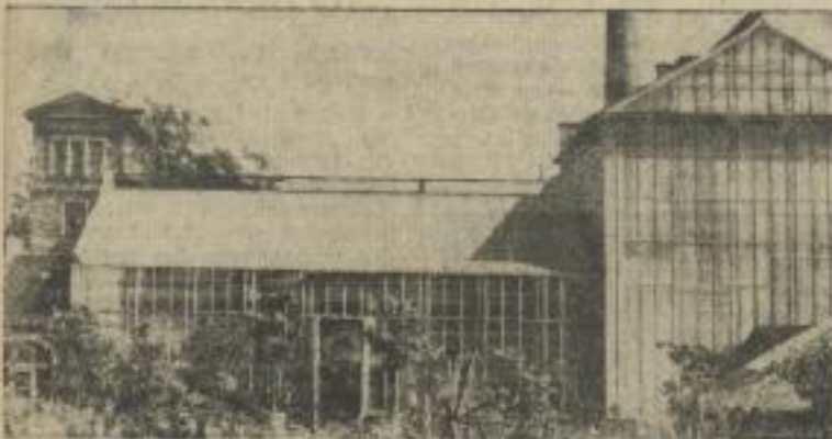
Die Gewächshausanlage 1956 nach dem Wiederaufbau.
