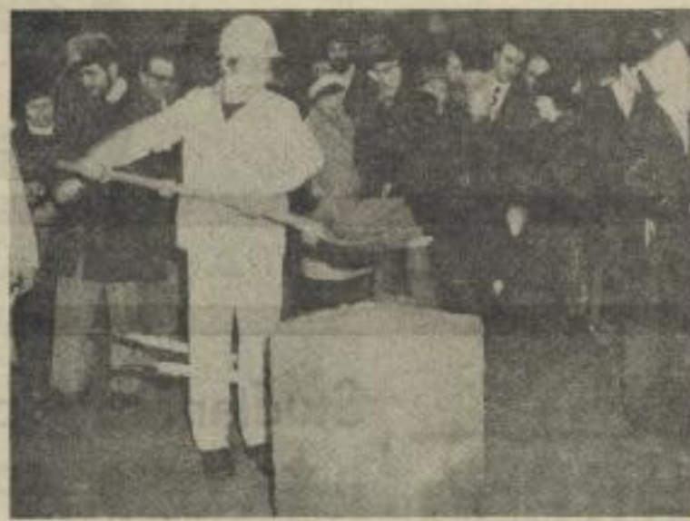
Während der Grundsteinlegung für das neue Bettenhaus am Bereich Medizin. Foto: HFBS/Glothe
