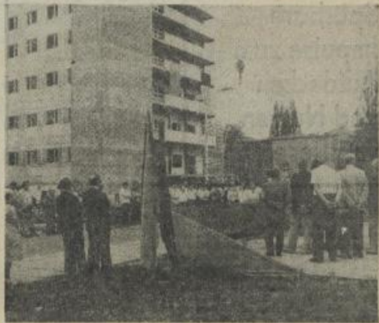
Richtfest wurde in diesem Jahr am Bettenhaus gefeiert. Termin- und qualitätsgerecht erbringt die Karl-Marx-Universität ihre Leistungen zur Realisierung dieses Direktivvorhabens.
