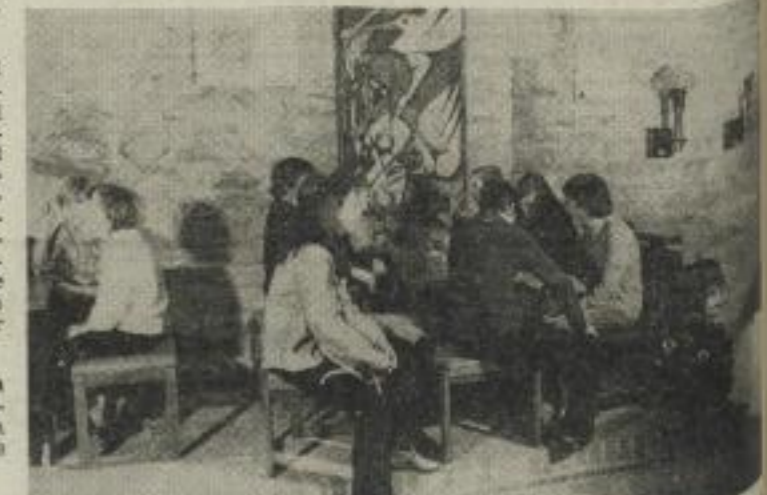
Seit dem ersten Spätschicht im Februar 1974 wurden in der Moritzbastei 140 000 Aufbaustunden durch Studenten geleistet. Über 35 000 m 2 Bauschutt aus den alten Gebäuden herauszuräumen, über 40 000 alte Mauersteine, die in Abbruchgebieten geborgen wurden, fanden beim Ausbau der Bastei Verwendung. 32 000 Stunden erbrachten die Freunde in den Jahren 1979/80. Seit der Eröffnung am 1. Dezember 1979 fanden über 300 Veranstaltungen, darunter fünf Ausstellungen, 85 Jugendforen mit rund 95 000 Besuchern statt.
