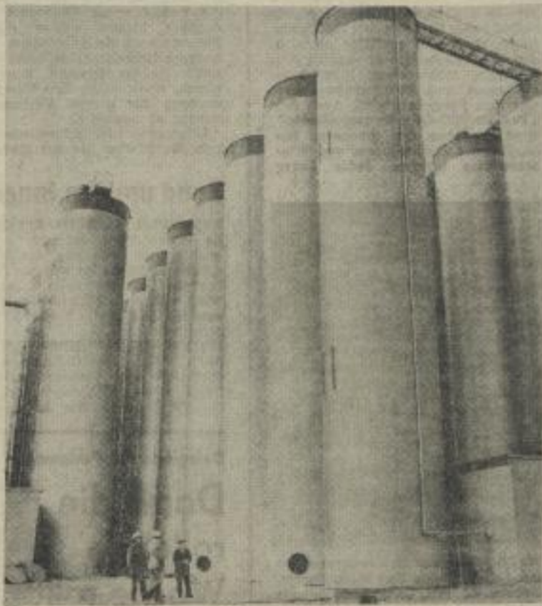
Auf der Grundlage der Großraumgärung wird Bier in diesen 24 Meter hohen Hochbehälter produziert. Jährlich 600 000 Hektoliter „kühle Blende“ können in der modernen Brauerei/Brennerei des VEB „Nordbrau“ im Getränkekombinat Neubrandenburg hergestellt werden. Dazu kommen jährlich 70 000 Hektoliter Ausgangsstoffe für die Spirituosenherstellung. Der VEB-Chemieanlagenbau „Germania“ Karl-Marx-Stadt lieferte die Anlagen zur Herstellung des adäquaten Gerstenzotels. Die hier angewendete Technologie entspricht absolut dem Weltniveau. Foto: ADN-ZB (Bartocha)
