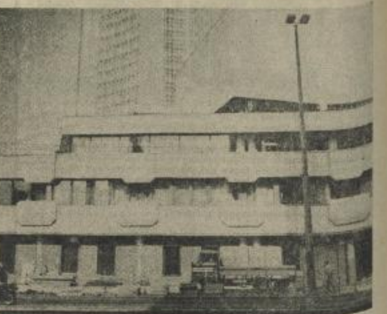
Der Platz vor dem Neuen Gewandhaus im Zentrum unserer Stadt nimmt in diesen Tagen mehr und mehr Gestalt an. Vor dem Hauptgebäude unserer Universität verlegten Kollegen aus dem Verkehrs- und Tiefbaukombinat der Messestadt kürzlich Gehwegplatten. Auch das Gelände zu beiden Seiten dieses Neubaus verändert sich von Tag zu Tag. Foto: Müller
