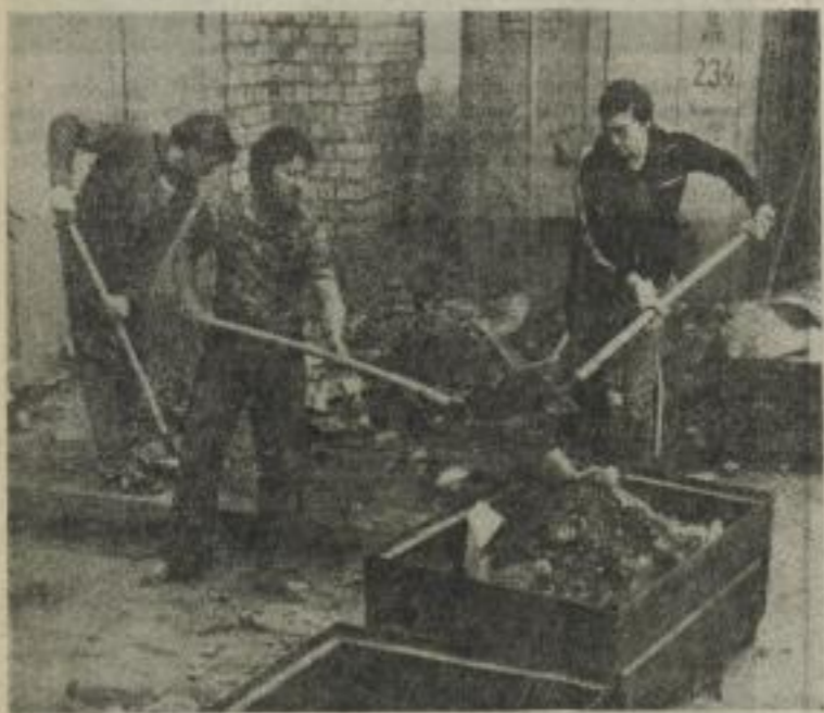
Aufräumungsarbeiten schafften Voraussetzungen für die Rekonstruktion einer Lagerhalle. Fotos: Michael Hübner
