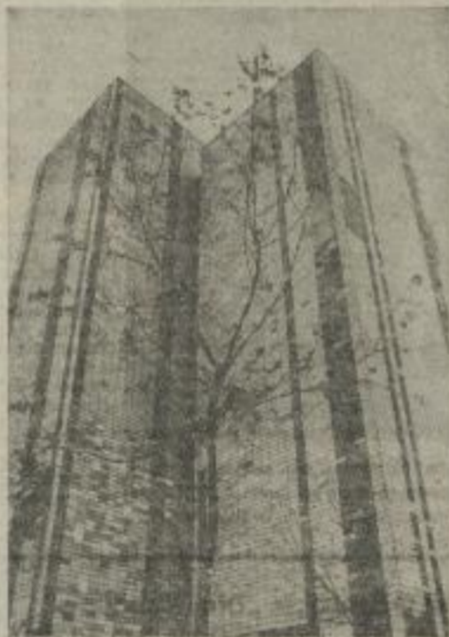
Im April 1980 begann die Belegung des Neuen Magazinrums, dafür waren zunächst 600 000 Dissertationen vorgesehen.
