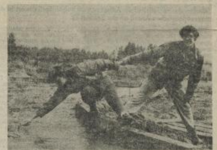
Mitglieder der Interbrigade Nowosibirsk '81 bei Arbeiten an einer neuen Straße. Fotos: privat
