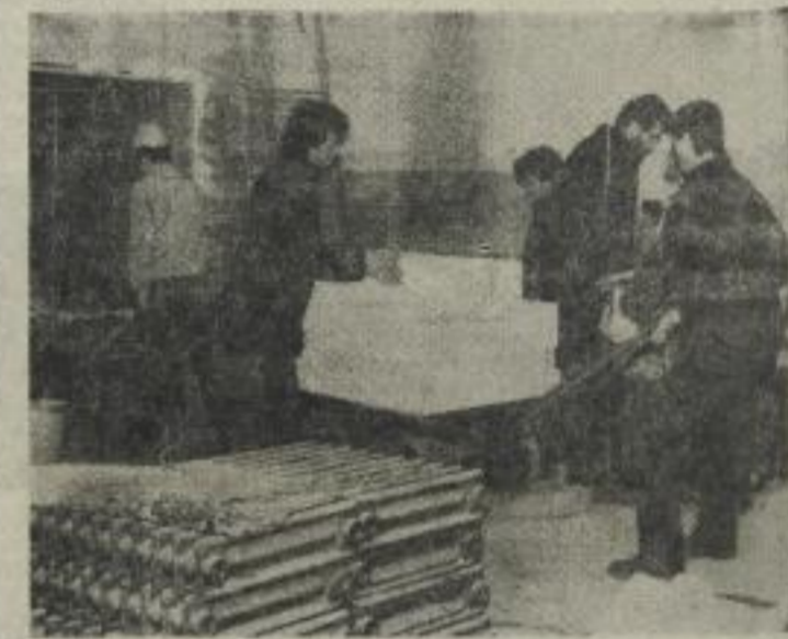
Lutz Schulze, Andreas Berger und Andre Glöckner am Anbau Chirurgie-Bauleiter Kollege Sini bestätigte, daß er mit der Arbeit der Jungen zufrieden ist. Foto: HFBS/Kranich
