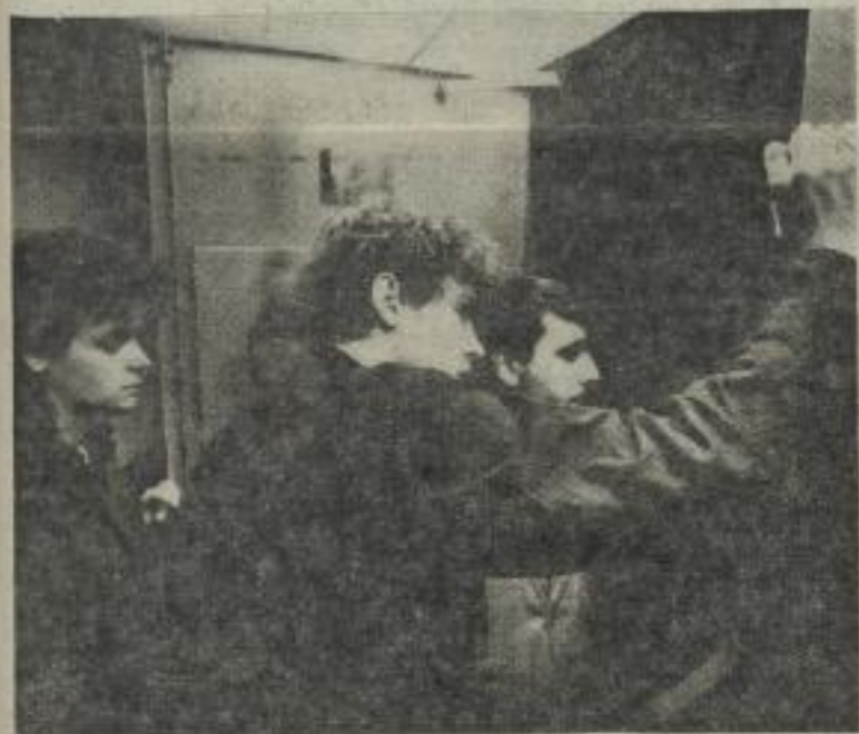
Mit dem Umbau der Kompensationsanlage in der 26. Etage des Hochhauses beschäftigten sich Jana Neubert, Lutz Torsten und Ulli Gsch (v. l. n. r.) aus der Brigade „E-Technik Stadtmitte“.
