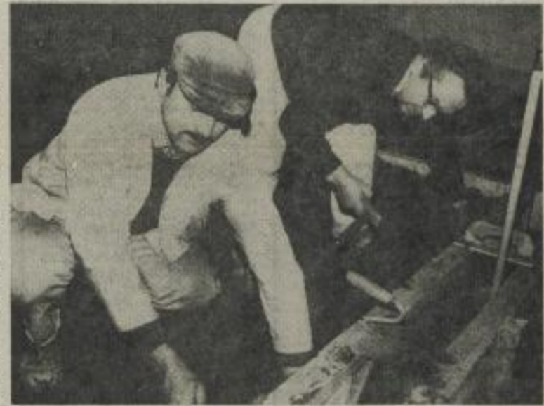
Der Einbau des Herzkathetermeßplatzes in der Klinik für Innere Medizin wird gesichert. Unser Fotograf beobachtete in der vergangenen Woche Paul Kuhnert und Andreas Lehmann bei Mauerarbeiten. Foto: RAHMAN SAYED
