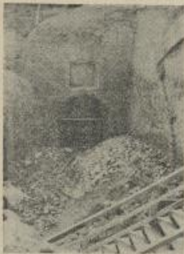
40 000 Kubikmeter Schutt mußten beseitigt werden.
