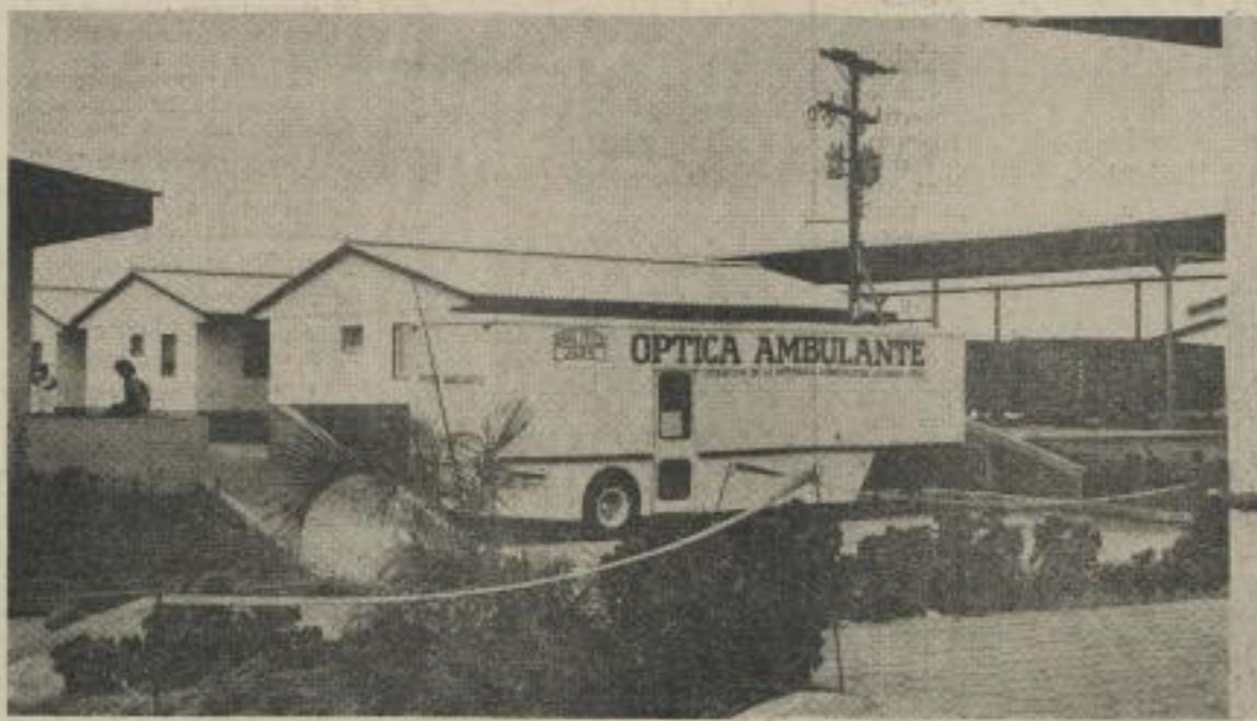
EINGANGSBEREICH DES HOSPITALS „CARLOS MARX“: Die DDR schenkte 21 Fertigteilhäuser. In der Optikerwerkstatt werden Patienten untersucht und Brillen gefertigt. Im Hintergrund rechts die Container des Operationstraktes. Fotos: Kaden
