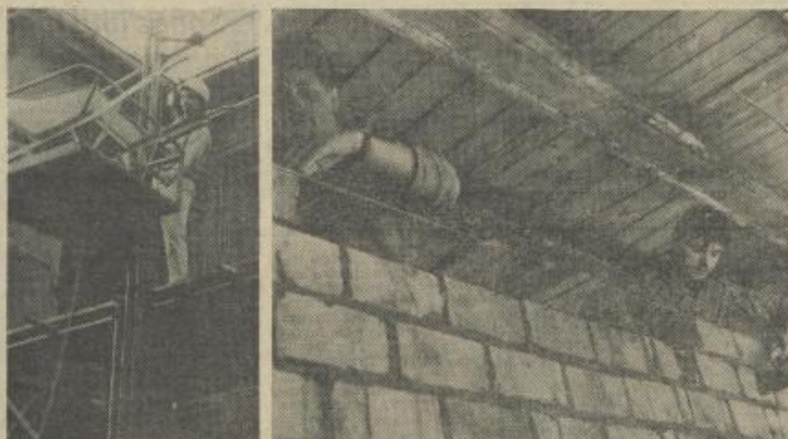
REKONSTRUKTIONSRARBEITEN IN DER KINDERKLINIK DES BEREICHES MEDIZIN DER KMU. UZ beobachtet mit der Kamera Ingolf Hoff (links), Thomas Malzahn und René Kiel (auf dem rechten Foto) vom VEB Hochbau und Rekonstruktion Grimma bei Mauerarbeiten am Gebäude der Klinik. Text und Fotos (3): BATBECH SEREETER
