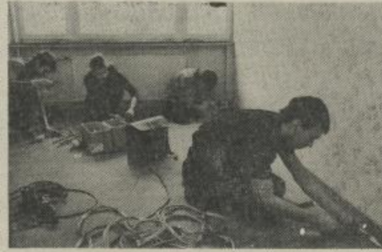
Fest eingebunden in die Erfüllung der Planaufgaben ist die Jugendbrigade Elektrotechnik der Betriebstechnik Stadtmitte der KMU. Auch bei den umfassenden Rekonstruktionsarbeiten im Studentenwohnheim „Jenny Marx“ helfen sie tatkräftig mit; hier bei Installationsarbeiten. Batbech Sereter
