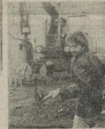
Beim Schwimmhallen- und Sportanlagenbau in Markkleeberg.
