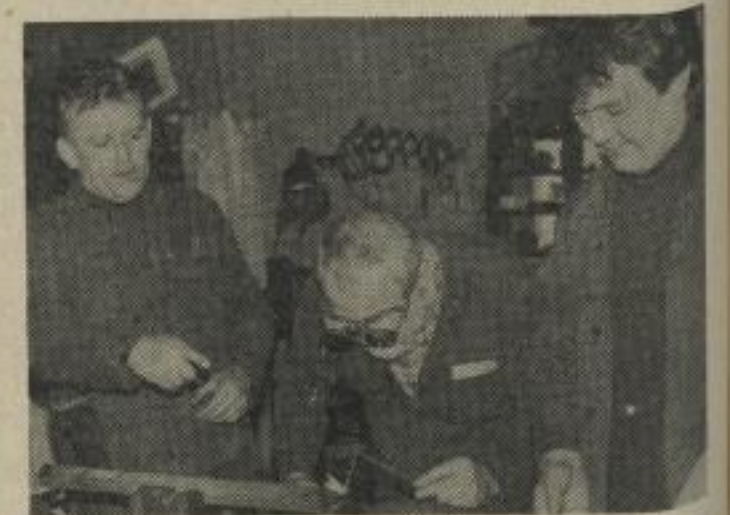
Das zehnköpfige Kollektiv der Heizungstechniker von der Abteilung Betriebstechnik Medizin des Direktorates Technik der KMU reparierte die Fernwärmeleitung von der Wärmeübertragungszentrale Stomatologie zur Sektion Chemie. Die Kollegen leisten eine anerkannte Arbeit und konnten bereits dreizehnmal den Titel „Kollektiv der sozialistischen Arbeit“ verdienen. Unser Foto zeigt Meister Werner Pohl sowie Manfred Ulmar und Falk Müschalle (v. l. n. r.) Foto: GOZBAJAR RENZENDOROSCH
