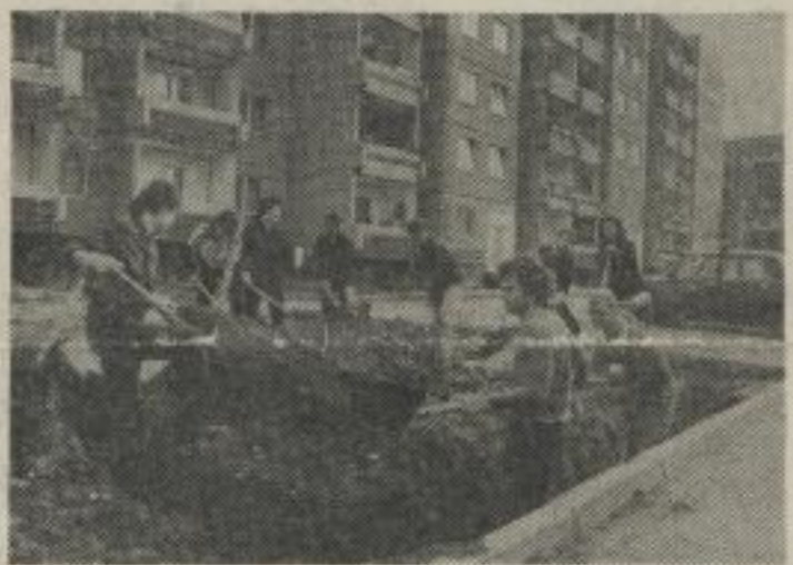
Im Neubaugebiet Leipzig-Paunsdorf helfen Studenten aus Irkutsk und Leipzig aus dem Interlager „Karl Marx“ bei Tiefbau- und Gehwegarbeiten. Foto: PETER KREBS
