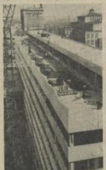
„Zügig werden die Arbeiten an Hauptgebäude (unser Bild) und Hochhaus, wo in dieser Woche die 28. Decke eingegeben wurde, fortgesetzt.“ - so konnte man am 21. Mai 1970 in der Universitätszeitung lesen. 1971 konnten dann die ersten Nutzer im Hauptgebäude unserer Uni einziehen. Foto: UZ (Archiv)
