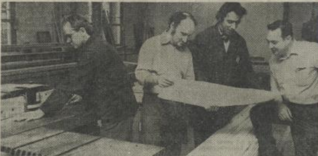
Die Kollegen des Meisterbereiches Tischlerei im DTmV haben alle Anstrengungen unternommen, um die gestellten Aufgaben anlässlich der Statusverleihung „TU“ in hoher Qualität zu erfüllen. Ein besonderer Beweis dafür sind die rekonstruierten Türen am Hauptgang des Böttcher-Baus.
