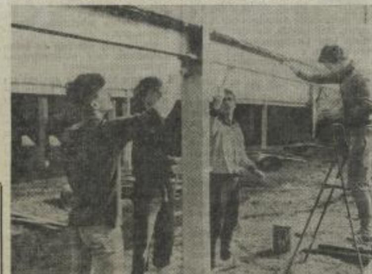
Der KK-Schießstand im Ernst-Thälmann-Sportforum erhält ein neues Gesicht. Mit Beginn des frühlingshaften Wetters begannen umfassende Rekonstruktionsarbeiten. Aktive Unterstützung wird dem Sportstättenbetrieb dabei durch die Kameradinnen und Kameraden der GST-Kreisorganisation der TU zuteil, die bei Abriss- und Malerarbeiten helfen.
