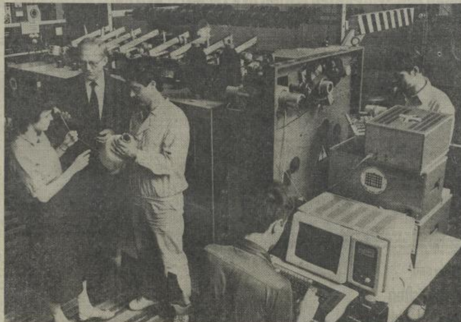
Das Kollektiv unter Leitung von Prof. Dr. Budig bei Arbeiten am Mehrmotorenantrieb mit Mikrorechnersteuerung.
