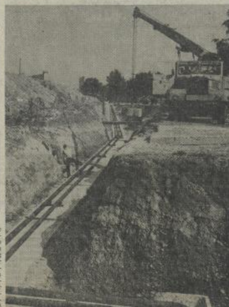
Ein erster wichtiger Bauabschnitt an der Fernwärmetrasse für das Universitäts-Erforschungslager Straße ist fertiggestellt. Es wird alles dafür getan, daß die Übergabe termingemäß erfolgen kann.
