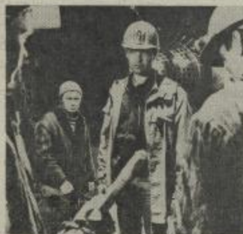
DER DURCHBRUCH erzählt von einem Tag heftiger Kämpfe gegen eisfesselte Naturkräfte beim Metrobau.
