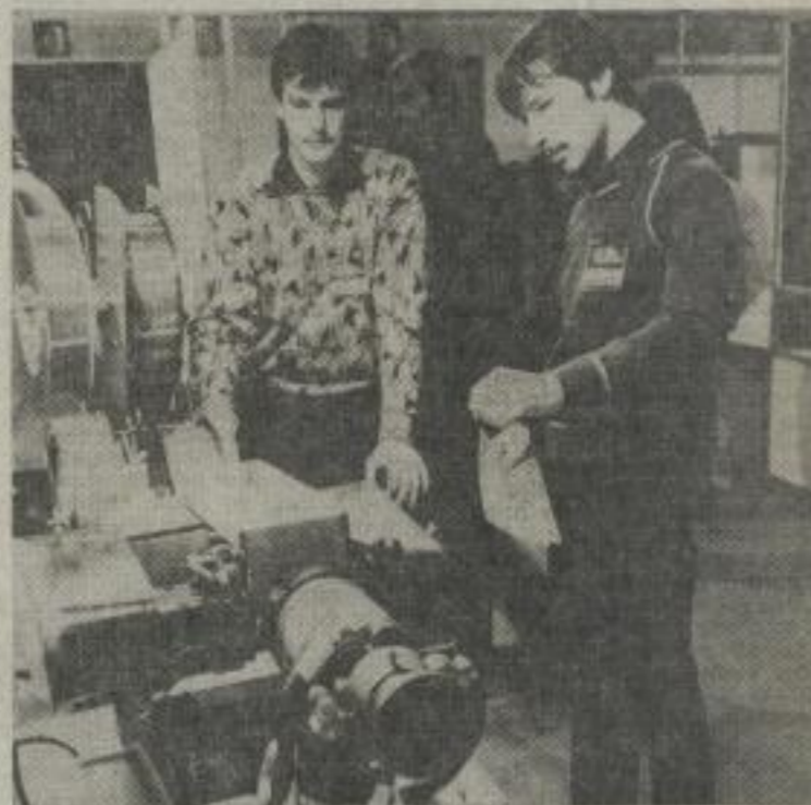
Ralf Herzer und Matthias Heinz von der Sektion Berufspädagogik stellen das Exponat „Mehrdrahtlichtbogen-spritzen von Sandwich-Schichten“ auf der Zentralen Leistungsschau vor. Mit dieser Weltneuheit (4 Patente) gelang einem Jugendforscherkollektiv in Auswertung sowjetischer Erfahrungen die Entwicklung eines Gerätes und Verfahrens für das Lichtbogenspritzen mit mehreren Drähten. Anwendungsgebiete sind die Bauteilregenerierung, Versiegelung, Beschichtung und Abschirmung für verschiedene Einsatzzwecke. Auf der Zentralen Leistungsschau wird diese Neuerung, durch die Material und Arbeitszeit eingespart werden, einem breiten Kreis potentieller Nutzer vorgestellt. Dabei verweisen die Aussteller auf einen Nutzen von 200 T.M., die das Verfahren im Einführungsjahr im VEB Schwerter-Emallierwerk Lauter brachte.
