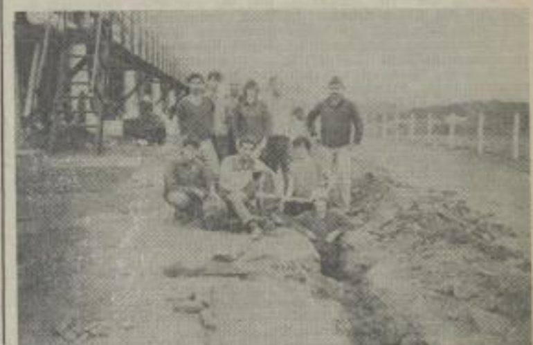
Der Brigadeleiter Volkmann Schneider (l. v. l., vordere Reihe) mit seinem Kollektiv beim Schichten eines Kabelgrabens an der Gaskühlung
