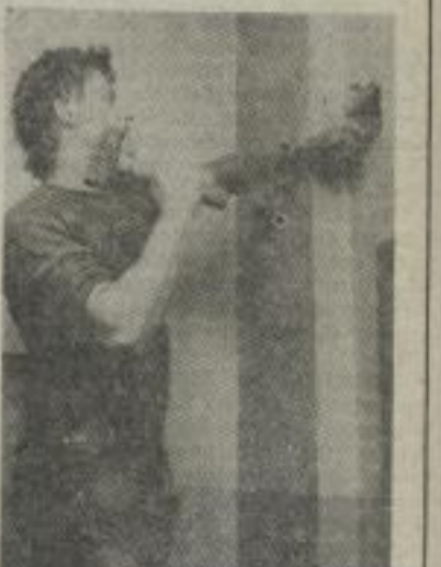
Jens Kirchhof, Maurer an unserer Universität, beim Anfertigen eines Mauerdurchbruchs.
