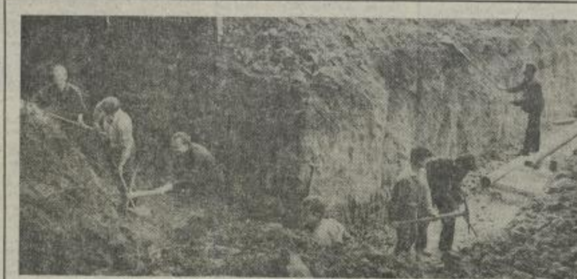
Eine wichtige Maßnahme für den Anschluß der Schule an die Fernwärmeversorgung ist der Bau der Heiztrasse. Unser Foto zeigt Studenten der SG 01 PPP 87 und 02 PPP 87 bei den notwendigen Erdarbeiten.
