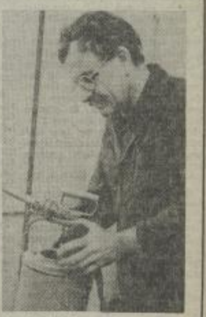
Manfred Pohler, Sektion E, sorgt für die notwendige Sicherheit bei Schweißarbeiten.
