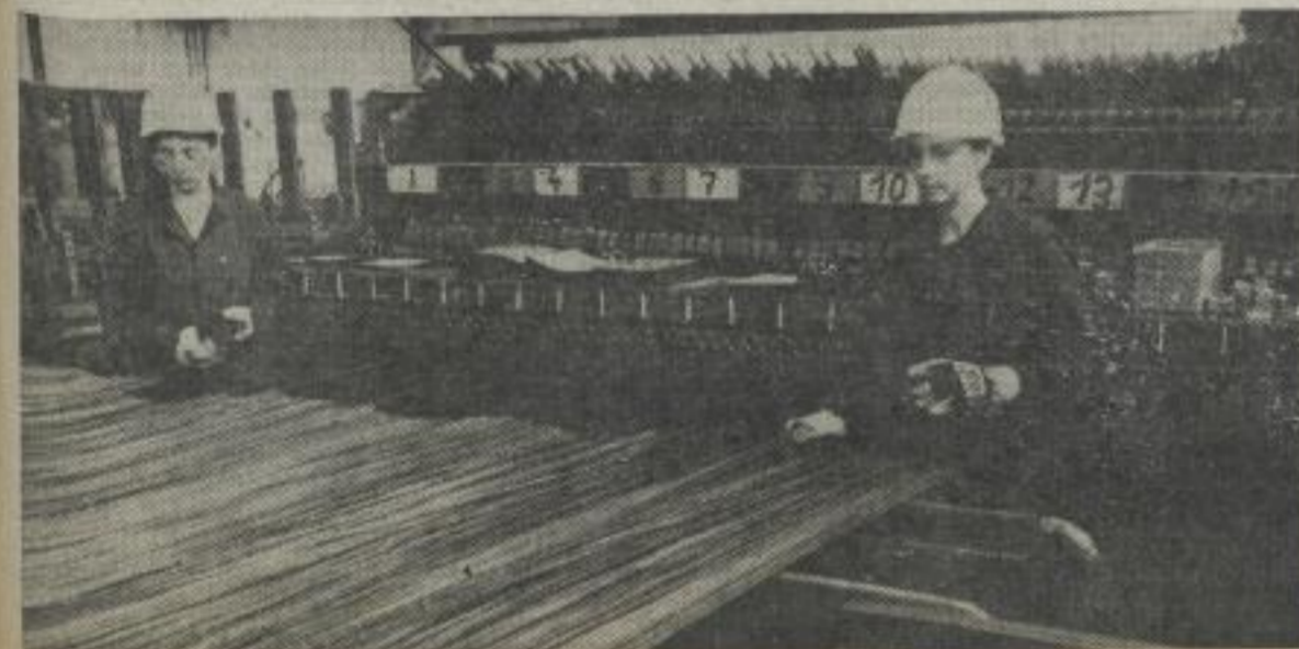
Die polnischen Pädagogikstudentinnen Marzena Kozink und Jolanta Pesko von der Universität Lodz arbeiten im Wohnungsbaukombinat, Betriebsteil Vorfertigung, an der Mattenschweißanlage.
