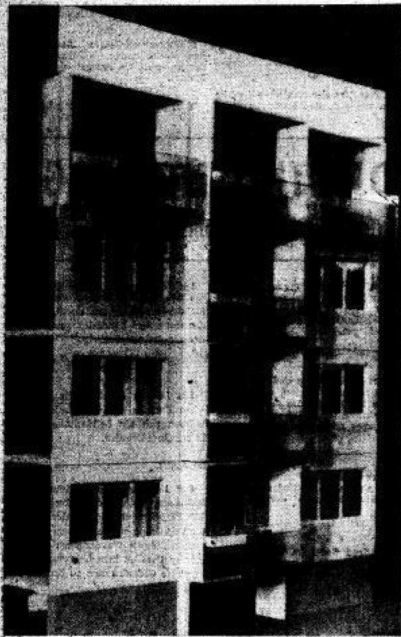
Vorkomplettiertes Loggia-Element zur variablen Gestaltung der Fassaden.
