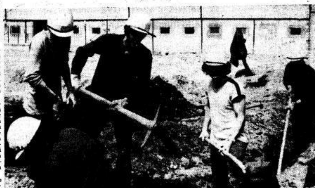
Mitglieder der Brigade LEIS „Bontsch-Brujewitsch“ des III. Internationalen Studentenlagers auf der Baustelle Köpkestraße, 3. v. l. Brigadier Georgi Smirnow. Fotos: Liebert/FBS
