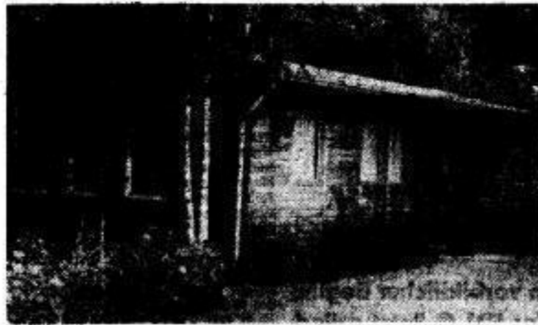
Das neue Sozialgebäude
