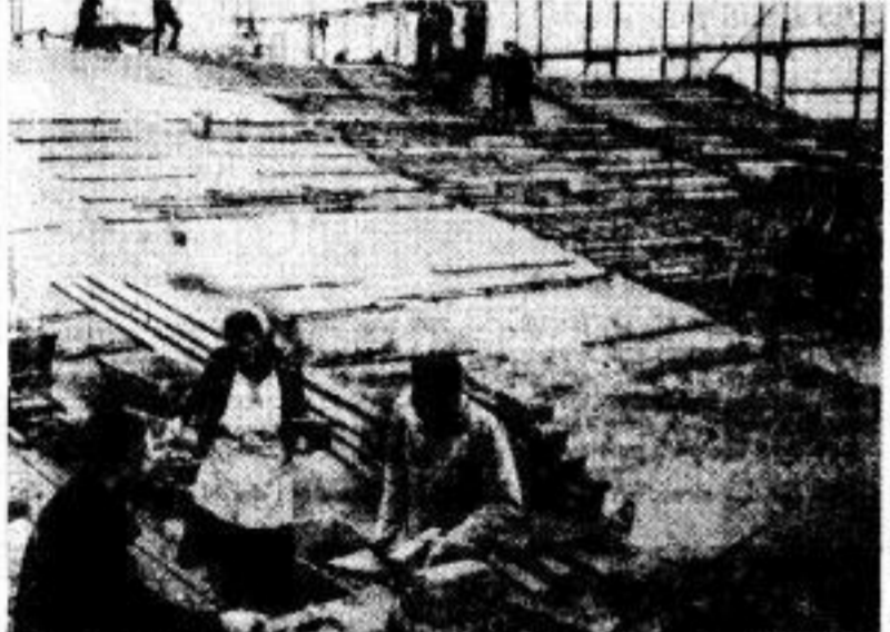
Seit 1948 wurden der TU für Bauinvestitionen 350 Millionen Mark vom Staatshaushalt zur Verfügung gestellt. Dieses Foto entstand am 3. November 1950 auf der Baustelle Zallescher Weg (Großer Physikhörsaal).
