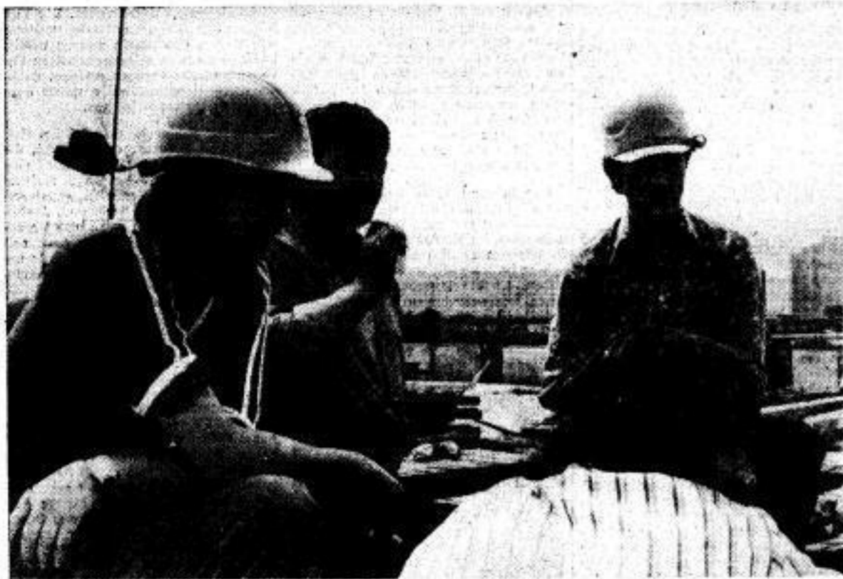
Mitglieder der Brigade Gabriele Friedrich (79/17/01) während einer Beratungspause auf dem Dach der zukünftigen Empfangshalle des Bahnhofes Berlin-Lichtenberg.
