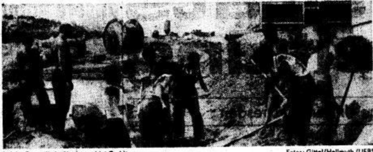
Auf der Baustelle im Neubaugebiet Gorbitz.
