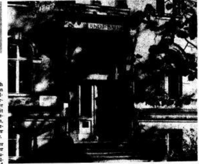
Der Berndtbau verdankt seine Errichtung der gewachsenen Bedeutung des Materialprüfungswesens. Fotos: Sütterlin
