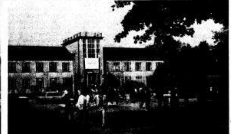
Mit dem Komplex des Barkhausenbaus begann nach 1945 der Neubau von Gebäuden und Einrichtungen. Fotos: Sütterlein
