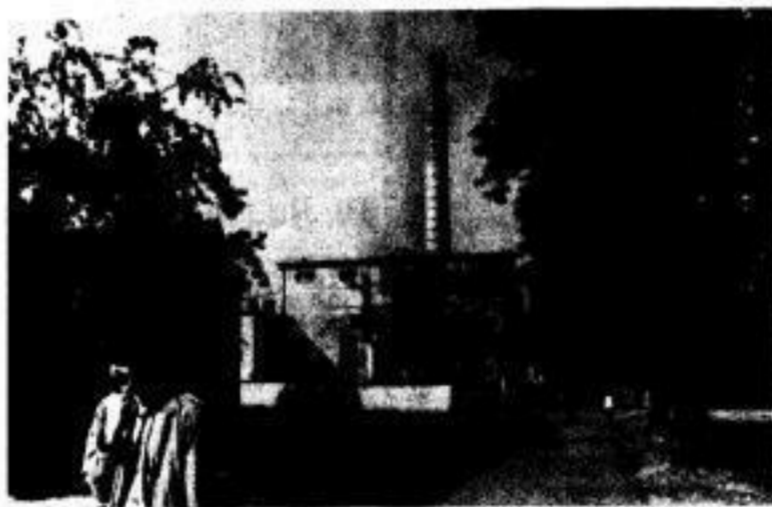
Blick auf unser Heizkraftwerk.
