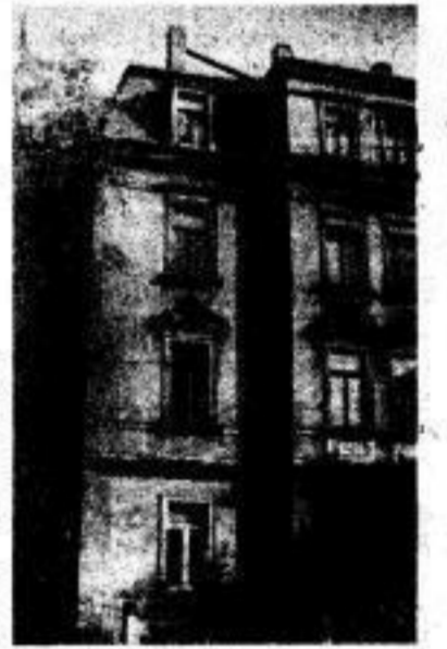
Mit 400000 Mark unterstützt unsere Universität die Rekonstruktion des Gebäudes Frankfurter Straße 5.
