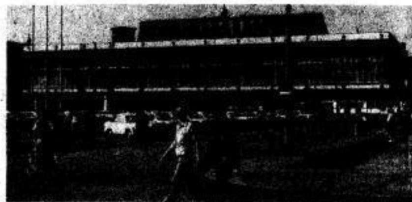
1969 erfolgte die Übergabe des Kulturpalastes. Fotos: Rohde, Sütterlin
