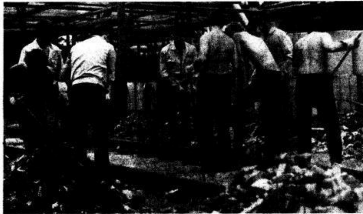
Die Leningrader Freunde bei Gleisenerungsarbeiten auf Linien der Dresdner Verkehrsbetriebe.
