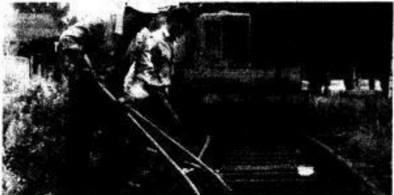
Die Studenten der Brigade Odessa halfen den Dresdner Verkehrsbetrieben.
