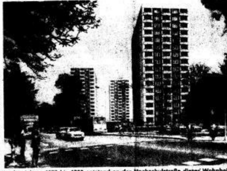
In den Jahren 1979 bis 1983 entstand an der Hochschulstraße dieser Wohnheimkomplex mit insgesamt 1590 Plätzen, 9 Millionen Mark wurden dafür investiert. Übrigens: 1988 verfügte die TU über 10900 Plätze in ihren Studentenwohnheimen. Foto: Lau/Richter
