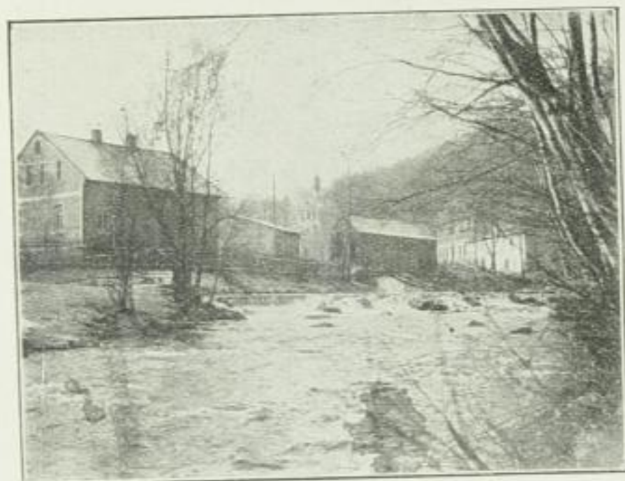
Schönheiderhammer: Die alte Muldenbrücke.
