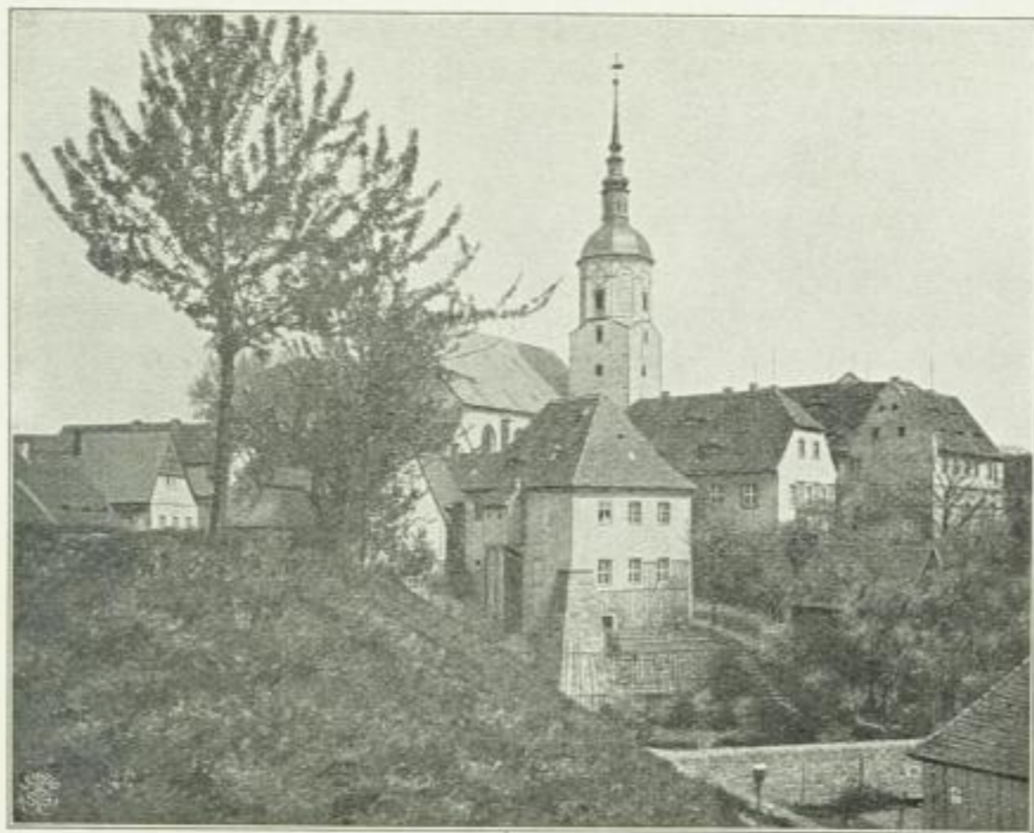
Kirche und geistliche Gebäude.
