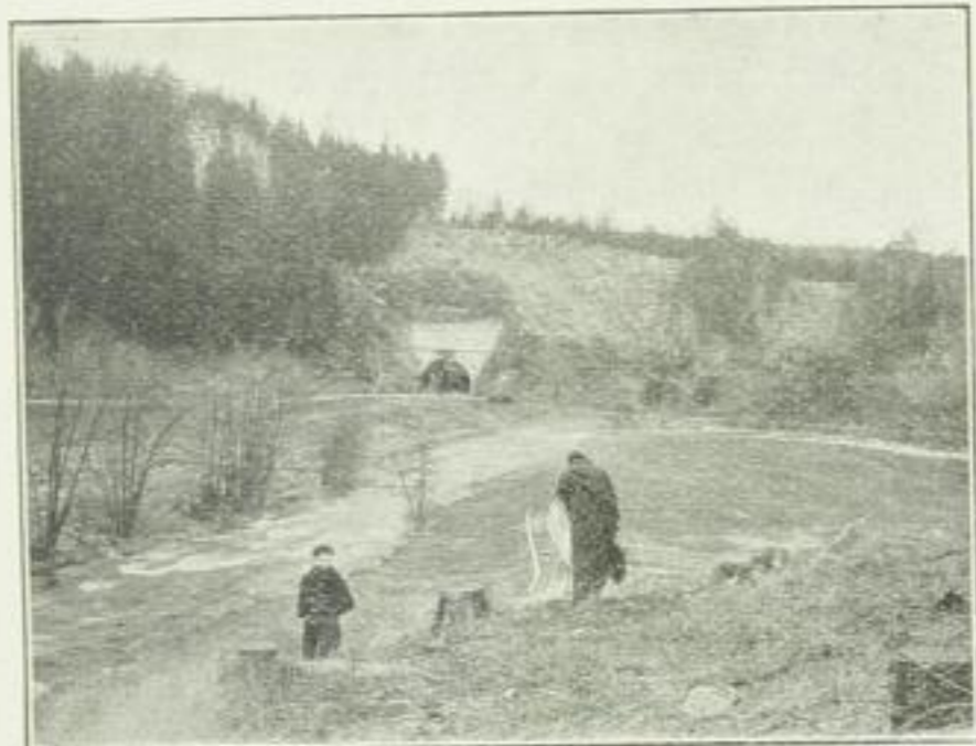
Schönheiderhammer: Tunnel der Eisenbahn.
