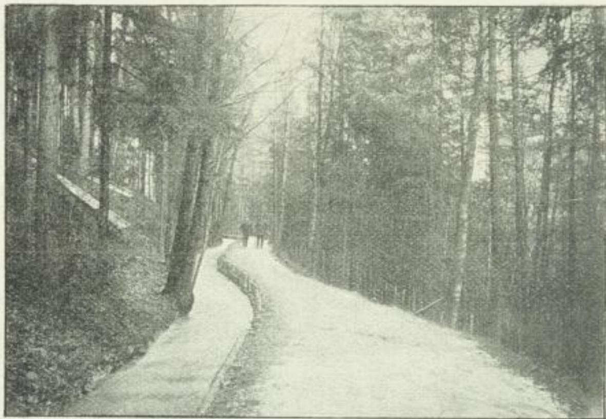
Floßgraben und Anstaltswald im Winter.
