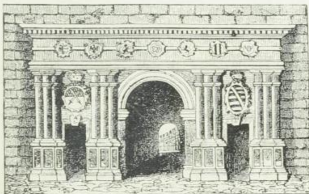
Das sogenannte „schöne Tor“ vor der Elbbrücke.
