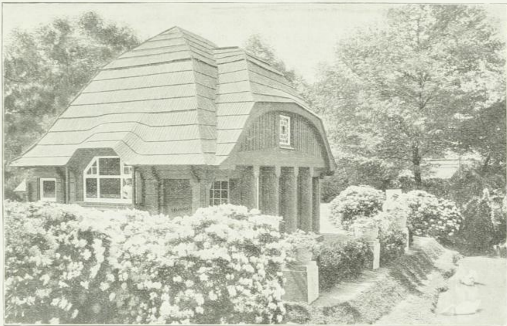
Barthhäuschen (Architekt W. Löffow, Dresden).
