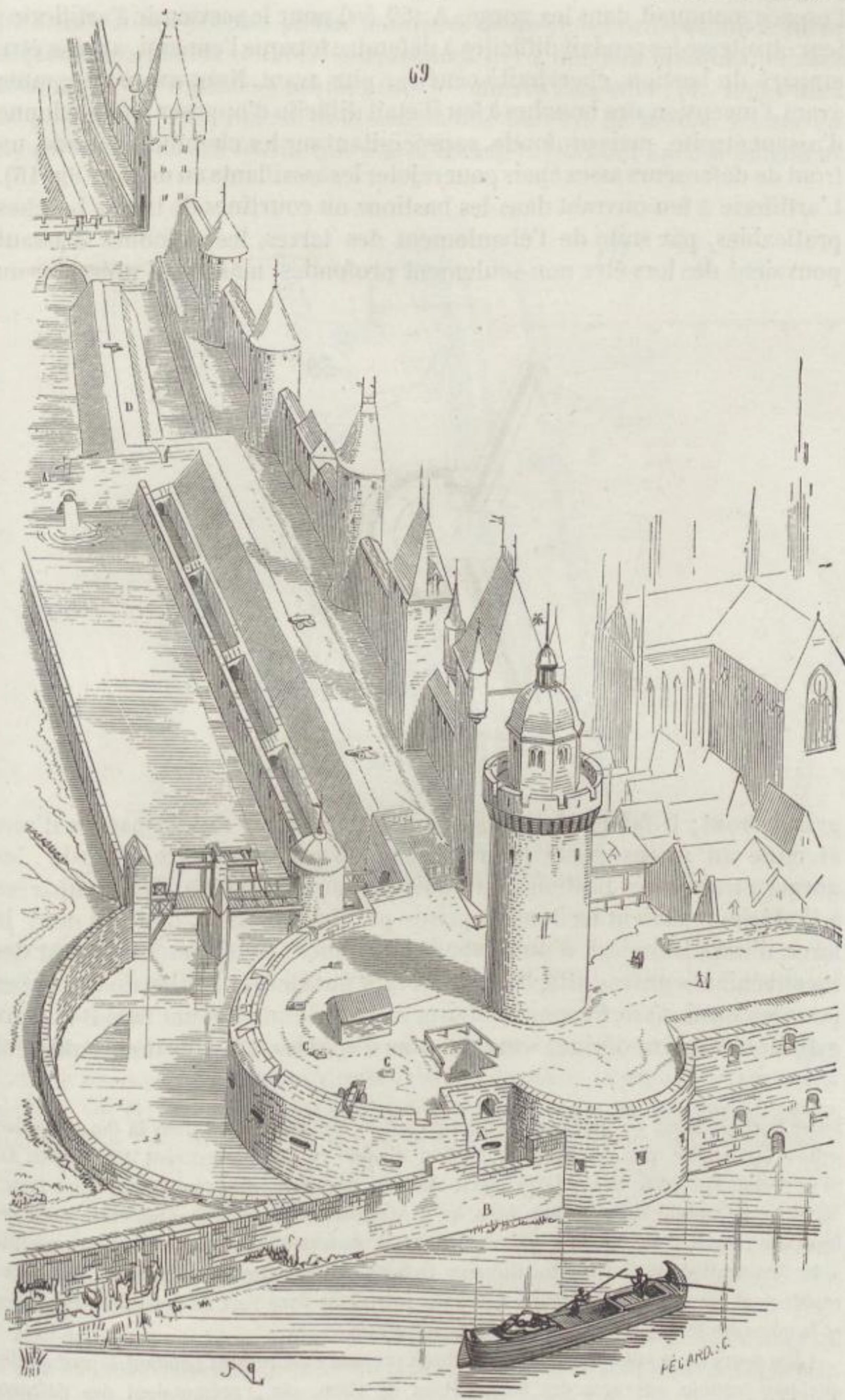
destinée à défendre le passage du fossé. On remarque des contre-forts qui viennent
