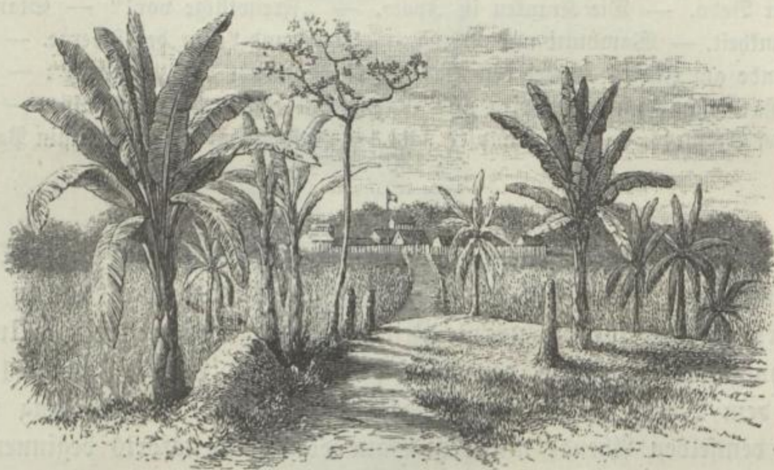
Ansicht vom Fort Bodo.
